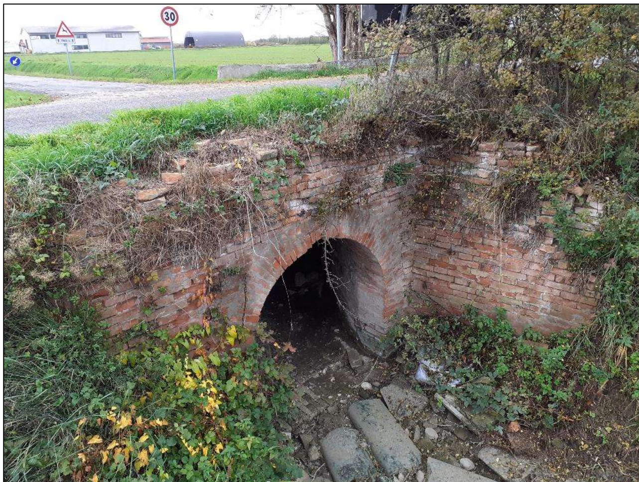
Figura 27: Vista del frontone di monte del ponte sulla Canaletta di Budrio.
